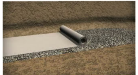
8. ábra: Geotextil lerakása
