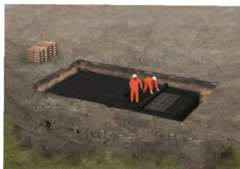
12. ábra: Csomagolás geotextiliával
