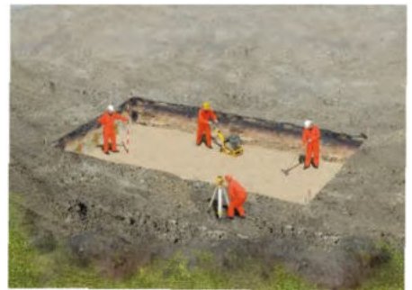
7. ábra: A kiegyenlített föld előkészítése
