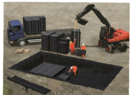
9. ábra: A szikkasztó blokk elemek elhelyezése
